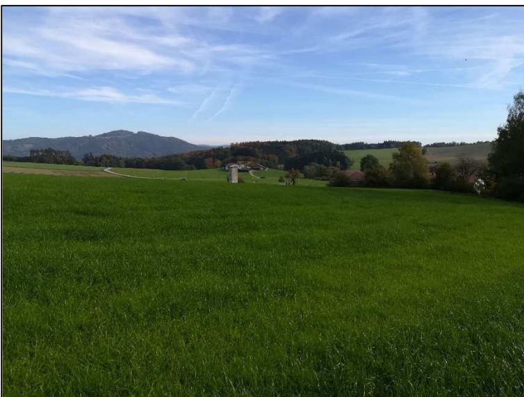
Blick von Westen nach Südosten Richtung Maiszell. Trafoturm im Hintergrund.
